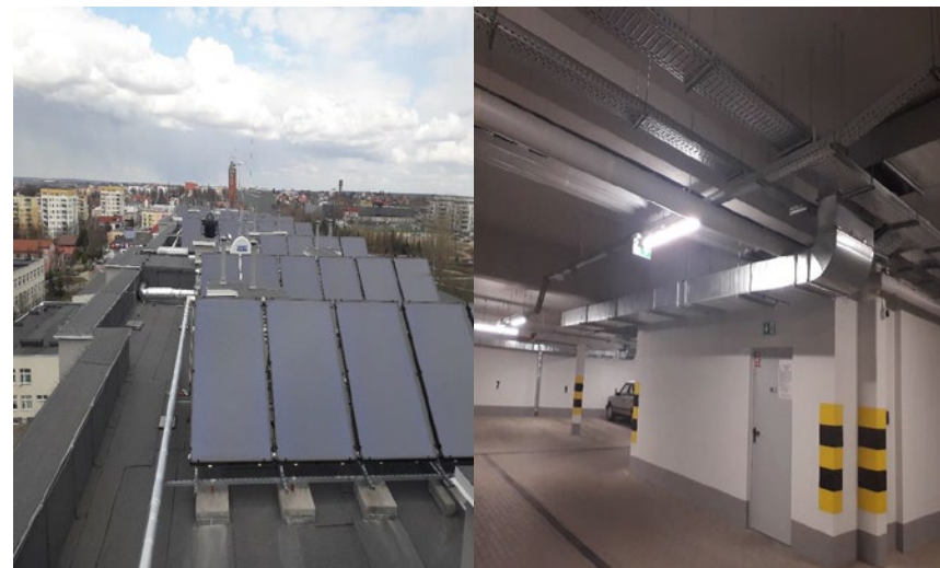
Instalacja wentylacji mechanicznej w budynku przy ul. Reymonta 7a.
